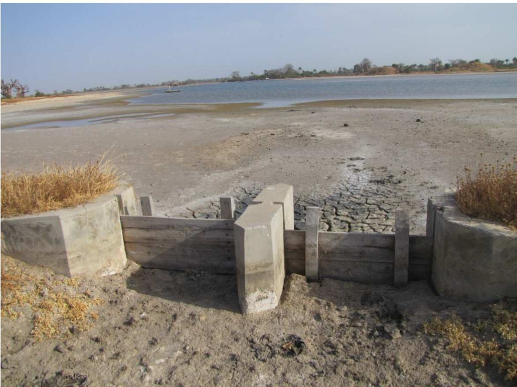
Figure A15-2 Barrage permettant de relarguer l'eau salée (photographie Mélody Braun)
